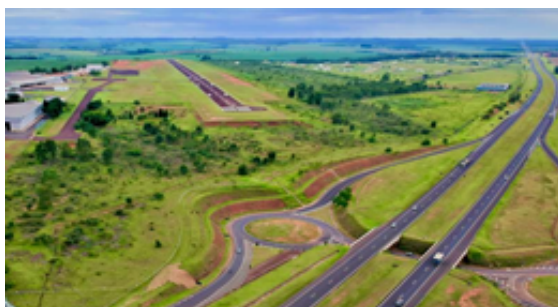
Figura 4 - Aeródromo Tancredo Neves em Botucatu
