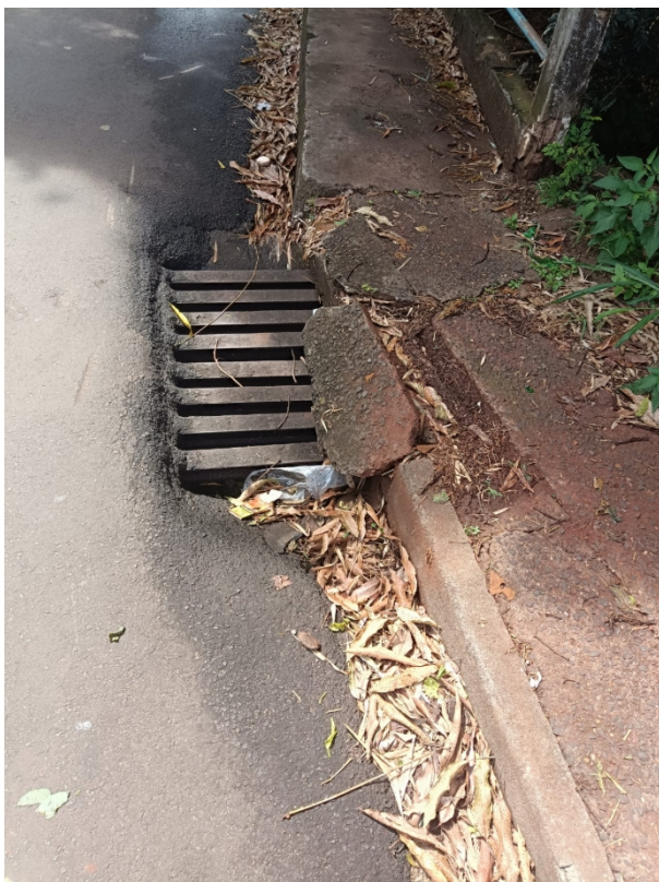
Fotos 14 a 17 - Rua Francisco Caricati
