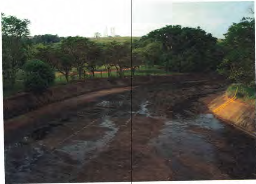
Figura 3 - Imagem do Vertedouro da Captação de Água de Botucatu em outubro de 2014
